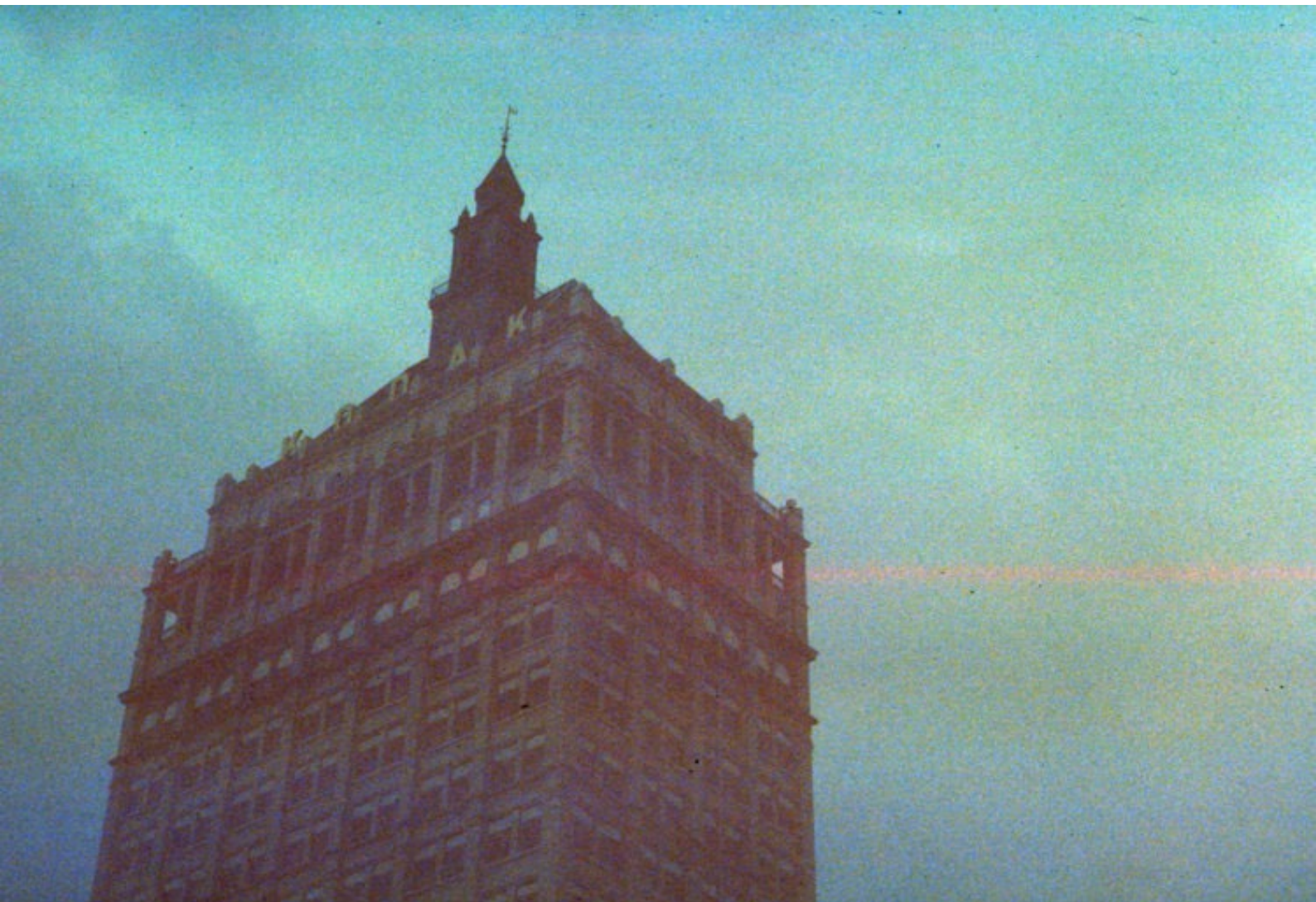
Edifício Sede da Kodak, Rochester, 2012. (Fotografia de Raquel Morais)
